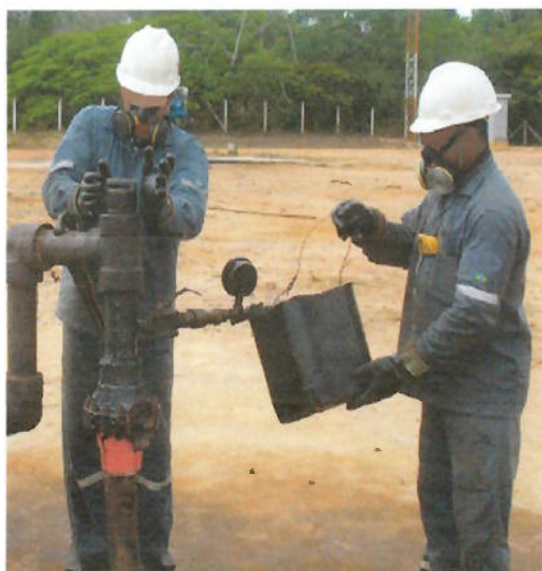
Figura 9 – Fechamento da Câmara e manobras para encaminhamento do PIG Fonte: A autora, (2009)
