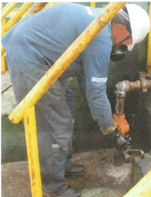
Figura 10 – Despressurização e Abertura da Câmara de PIG Fonte: A autora, (2009)
