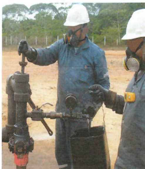
Figura 8 – Abertura da câmara e introdução do PIG Fonte: A autora, (2009)
