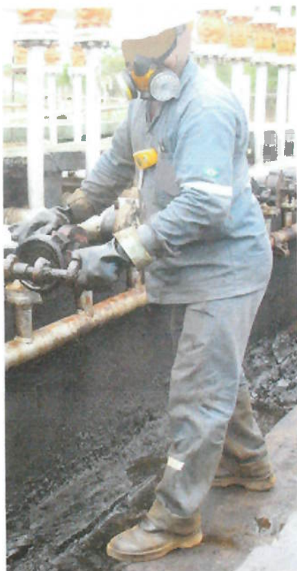
Figura 11 – Abertura da Câmara e Recuperação do PIG Fonte: A autora, (2009)
